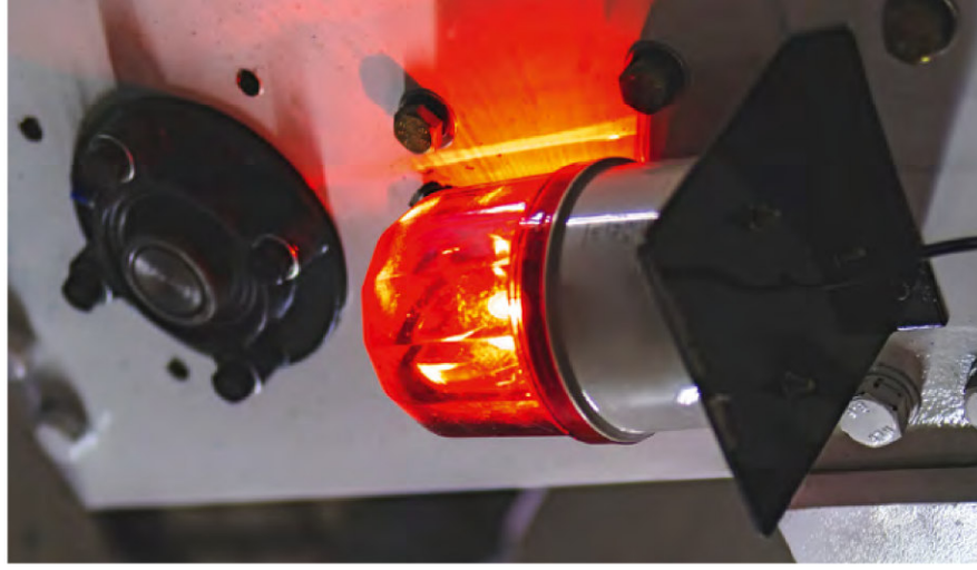
Zwei-Sinne-Prinzip: visuelle und akustische Alarmsignale im Brandfall.
